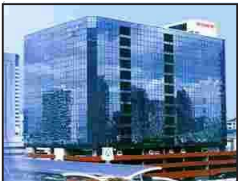
Mahatun Plaza Building อาคารมหาทุนพลาซ่า
